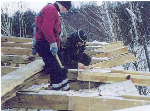
Abb. 13: Die Schüler werden bei der Instandsetzung der Gebäude mit einbezogen.
