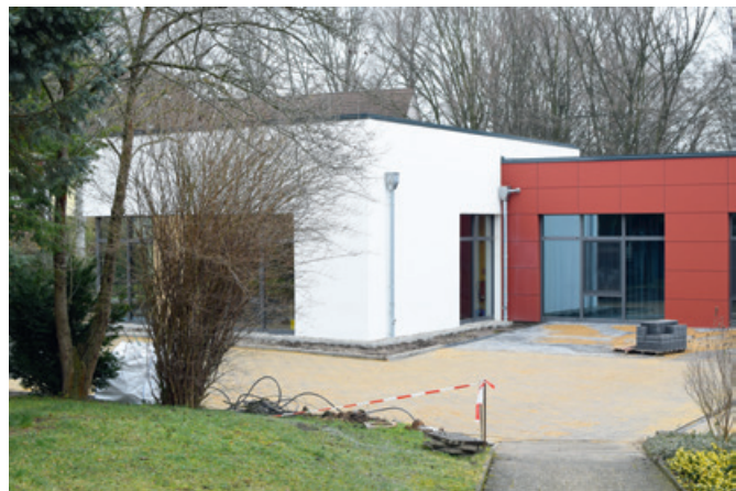
Am Tag der Einweihung bleibt noch manches zu tun. Die Außenanlagen müssen noch fertiggestellt werden.
