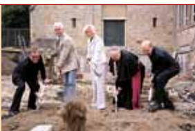
Erster Spatenstich für das neue Dom-Museum. Es soll künftig in der Antonius-Kirche seinen Platz finden.
