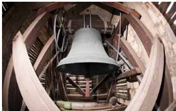
Sie sind verschlissen: die alten Glocken des Domes.
